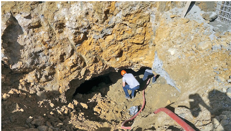
Fig. 5: Freigelegter Zugang zum Karsthohraum (Bild Th. Rüegg, 04.08.2017).
